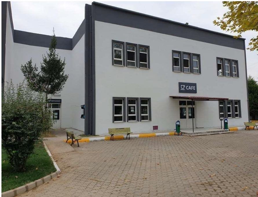
Yemekhane ve Kantin Binası
