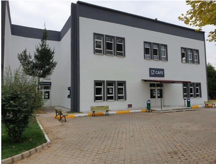
Yemekhane ve Kantin Binası
