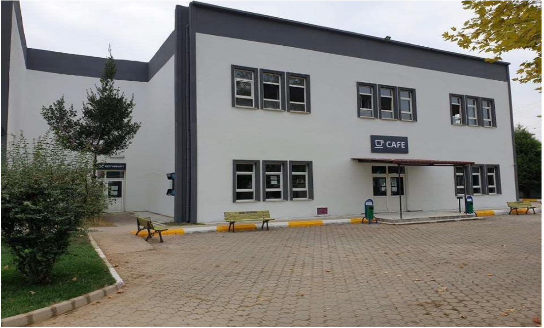
Yemekhane ve Kantin Binası
